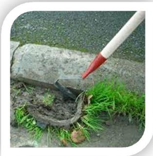
Les finitions sont effectuées au pic bêche ou à la débroussailleuse à lames réciproques de type Auxicut.
